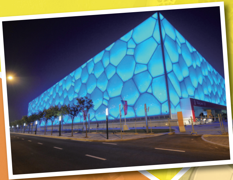
▲ 2008년 베이징 올림픽에서 수영 경기가 이뤄진 '워터큐브'. 거대한 직사각형 외관이 3차원 보로노이 다이어그램 모양으로 이뤄져 있다. 마치 비누거품 모양과도 비슷한 워터큐브는 무려 634개의 입체로 이뤄져 있다.
